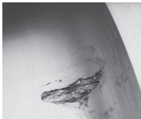
obr. 5.2 Ilustrační fotografie únavového poškození na oběžné dráze.
